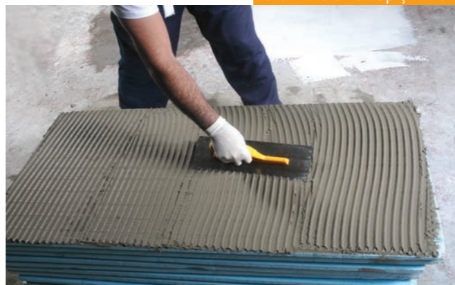
Düğünlü yüzeylere uygulama yapılacağı zaman levhanın arkasına sürülen harç tarak ile eşit bir şekilde yayılır. Taraklama yapıldıktan sonra kenarlara harç taşmamasına özen gösterilir.
